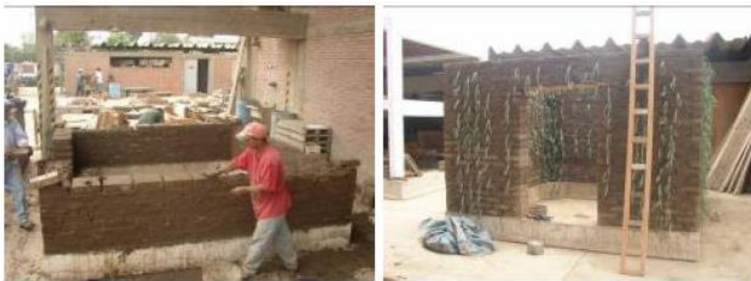
شکل ۳- ساخت مدل های خشتی
