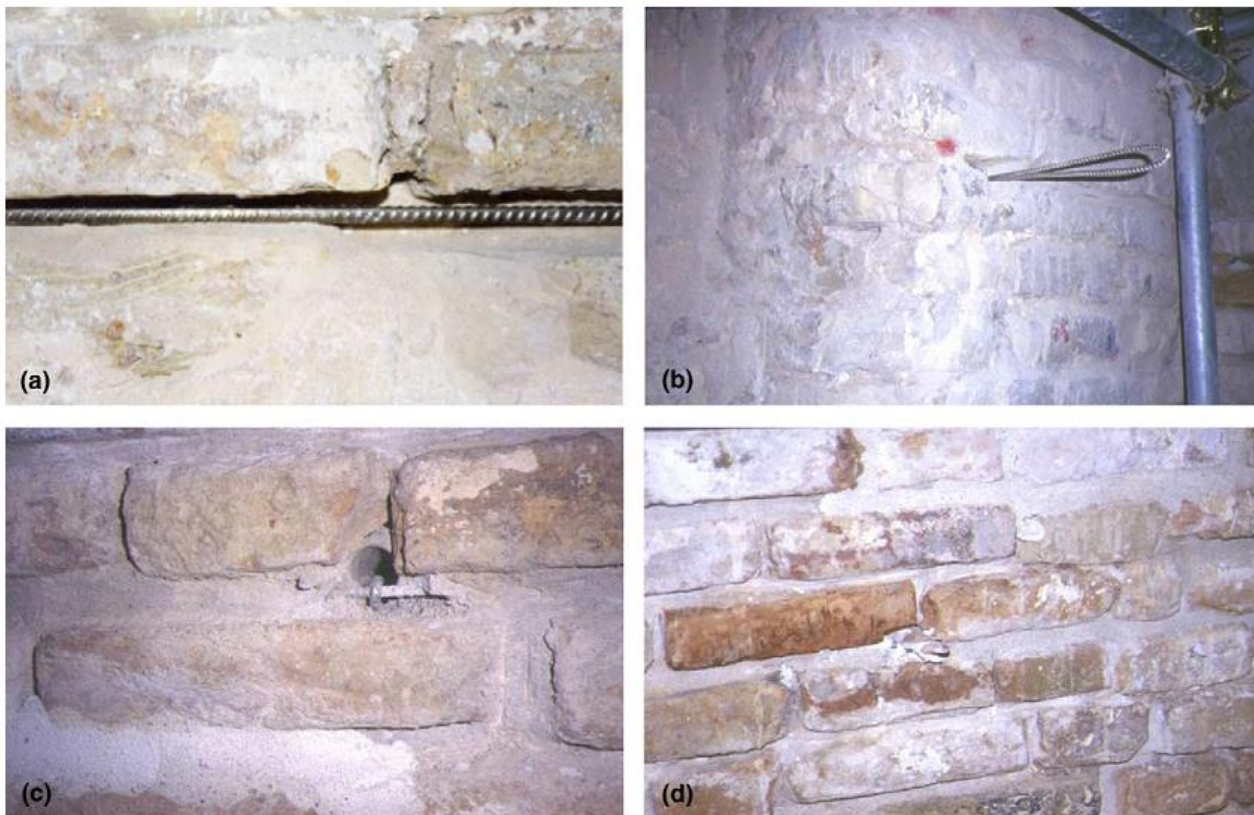
شکل (۷): (a) - جایگذاری آرماتورهای تقویتی (b) - جایگذاری آرماتورهای میانی (c) - محل اتصال بعد از بند کشی مجدد (d) - نمای نهایی
